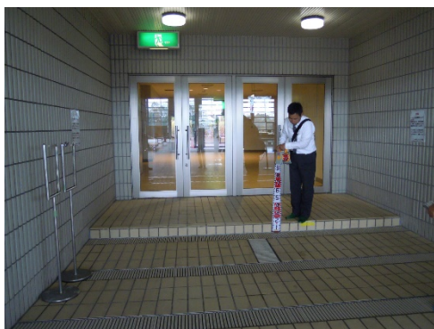
出入口付近の段差
