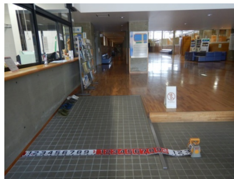
玄関部段差の注意喚起
