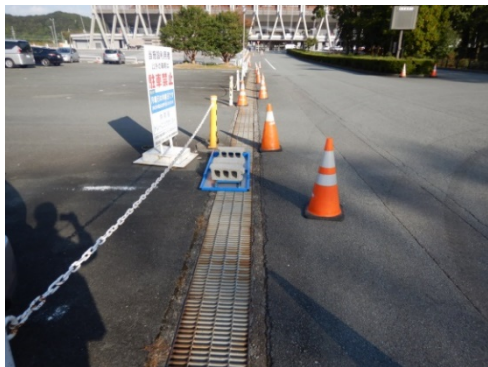
網目の大きなグレーチング
